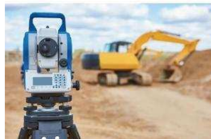
Implantation à la station totale
