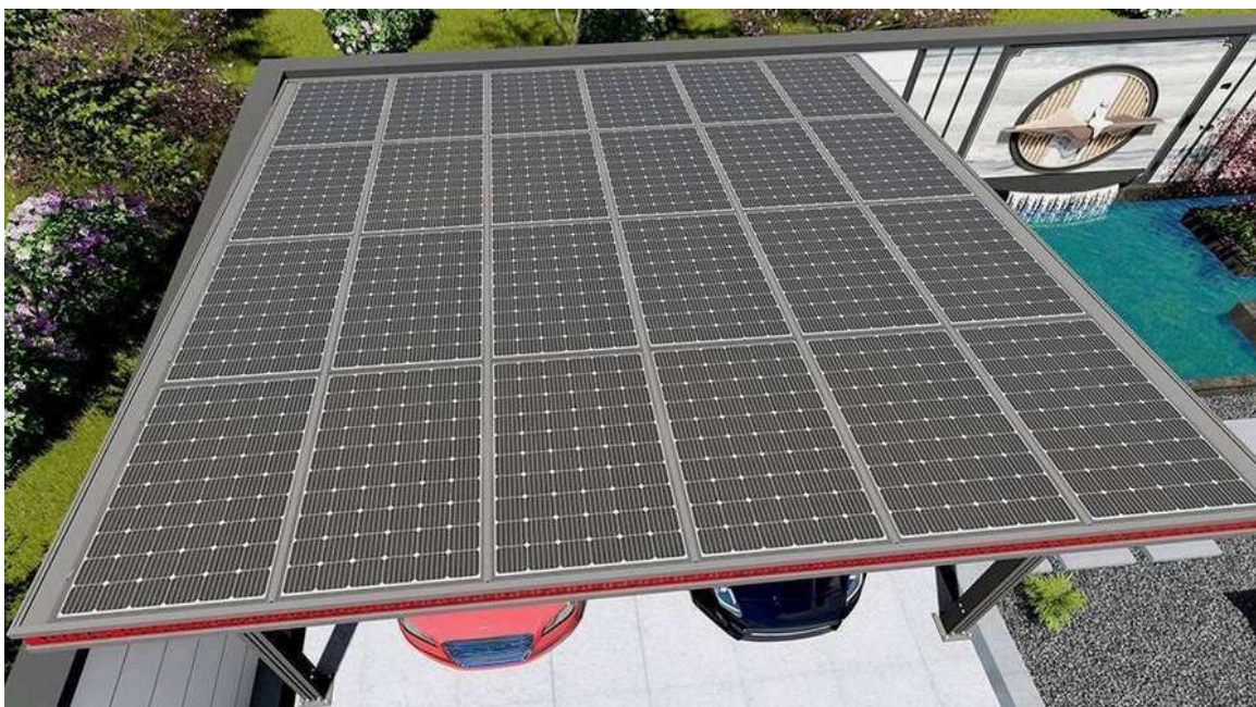
Toiture intégralement photovoltaïque, 24 modules en configuration 4 × 6
